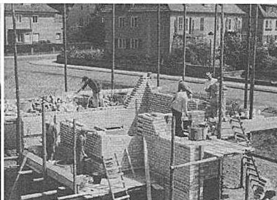
Blick auf die Sakristei
